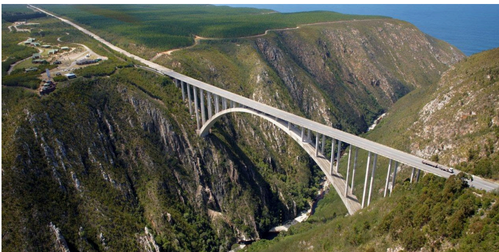
Die Bloukrans Bridge liegt an der Nationalstrasse N2 entlang der Garden Route und führt über den gleichnamigen Fluss. Bild: Youtube
